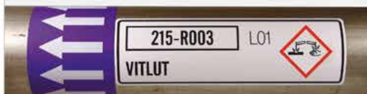
Exempel på märkning med piltejp och dekal med egen utformning. (Stora Enso Skoghalls standard: Mediafärg och flödesriktning med piltejp, rörnummer, klartext, mediakod samt kompletterat med CLP/GHS-piktogram). Dekaler kan göras helt enligt er standard.
